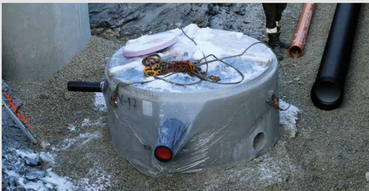
SIKKERT: Krympeplasten blir først fjernet ved montering av kummen. Foto: NOBI
