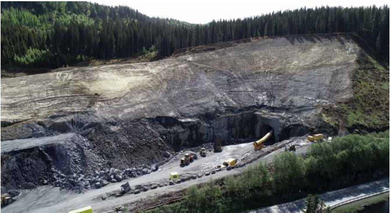
SPRENGES: I denne delen av den nesten fire kilometer lange tunnelen vil renseanleggene bli montert. Foto: Statens Vegvesen
