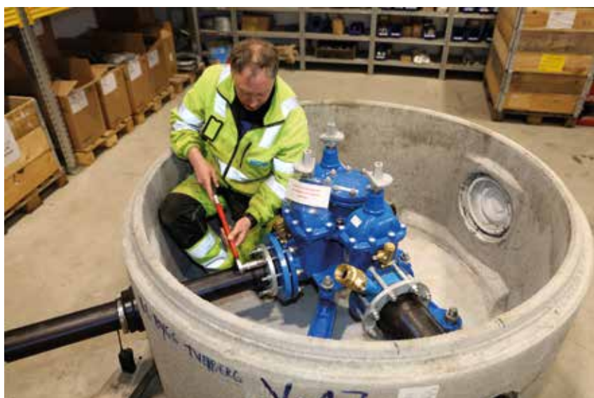
Hygienisk: Montasje innomhus sikrer at alt skjer i kontrollerte og rene omgivelser. Foto: NOBI
