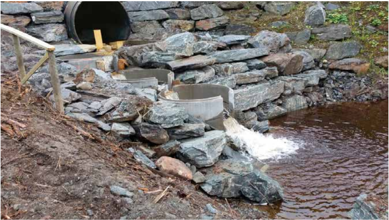
LEVANGER: Midt-Norsk Betong leverte betongterskler som ble montert inne i røret og flere kummer som fungerer som ei fisketrapp.
