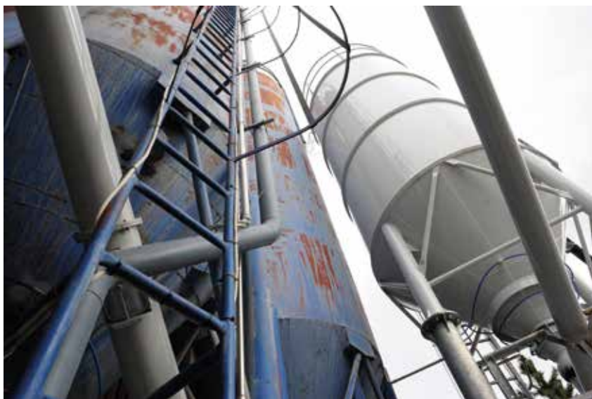
SILIKA: Silika blir nå kjørt i tørrform i stedet for slurry. Det gir bedre kontroll over produksjonen.
