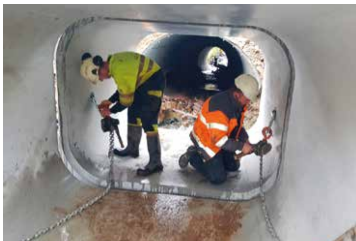
Montasjen av Box Culvert har gått over all forventning. Foto: Guttorm Garvik, Sandnes Kommune - Teknisk.
