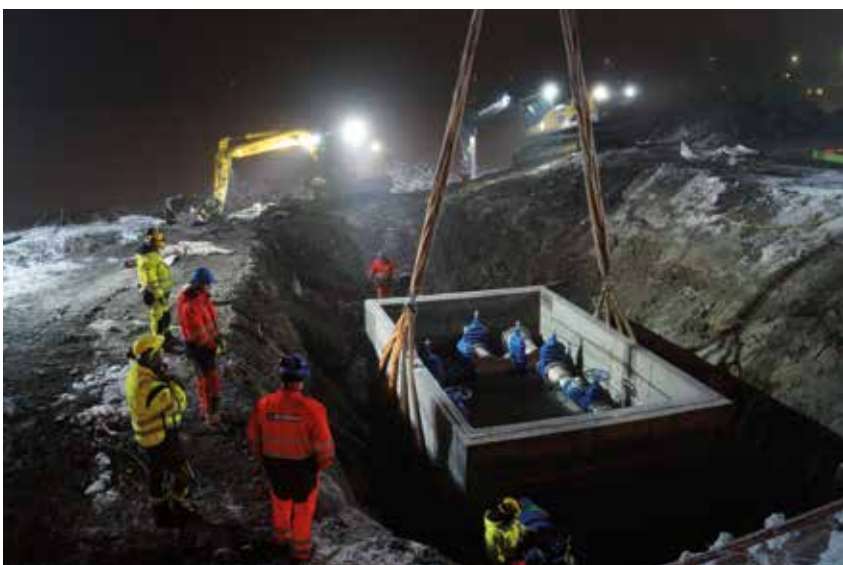
KNIRKEFRITT: Godt ut på natten blir vannkummen trygt senket ned. Foto: Petter Narmo
