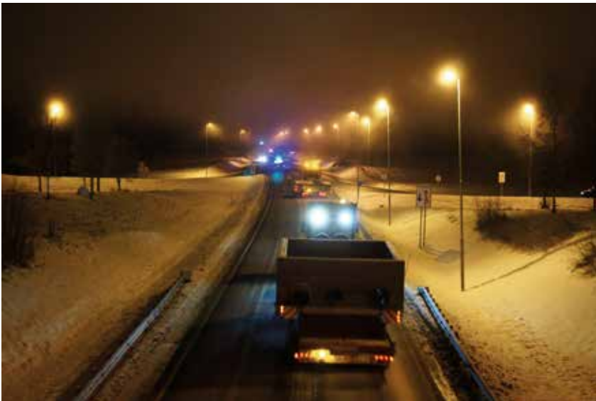
TUNG LAST: Både Statens vegvesen og Politiet er med på ferden, når topp-platen (32 tonn) og bunnseksjonen (59 tonn) fraktes til Sandvika. For en kortere periode blir E6 stengt. Foto: Petter Narmo.
