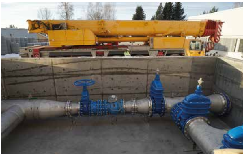
VEKT: Norconsult har jobbet mye med å holde vekten nede, på grunn av utfordringer knyttet til transporten var det et mål å få kummen under 60 tonn. Foto: Mona Sprenger
