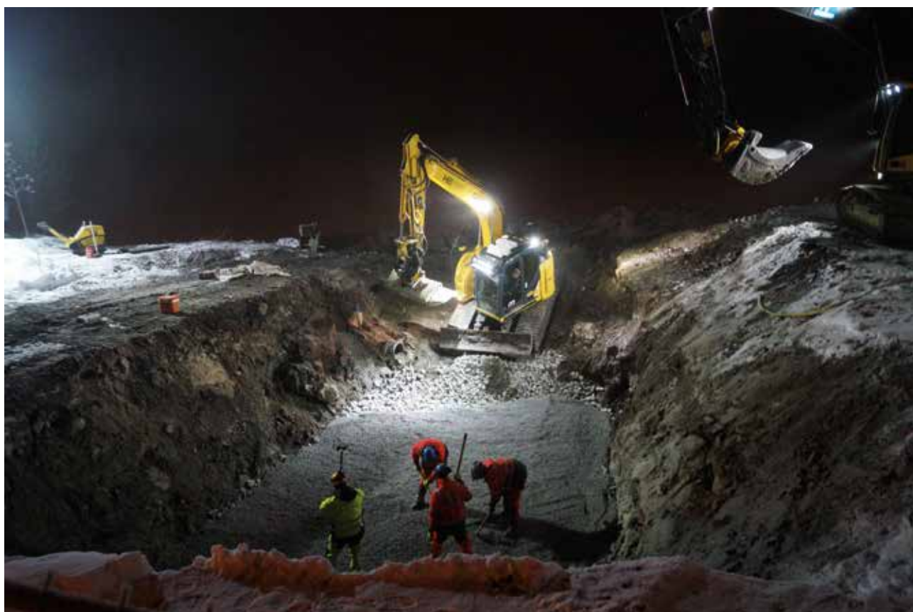
FORBEREDELSE: Det er mye som må være på plass før kummen kan løftes på plass. Naturreseptet i Åkersvika gjør at det er strenge restriksjoner på når gravingen kan foregå samt at vannstanden i Mjøsa også ikke kan være for høy. Foto: Petter Narmo
