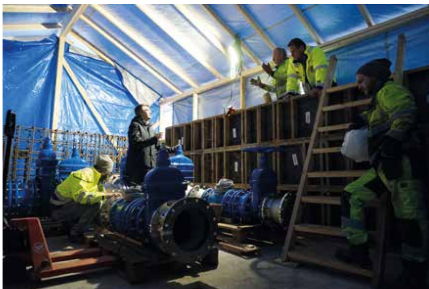
TEAMARBEID: Det har vært et svært godt samarbeid mellom de ulike fagdisiplinene i prosjektet. Narmo Betong har satt opp et eget telt for produksjonen på anleggsområdet sitt. Foto: Mona Sprenger
