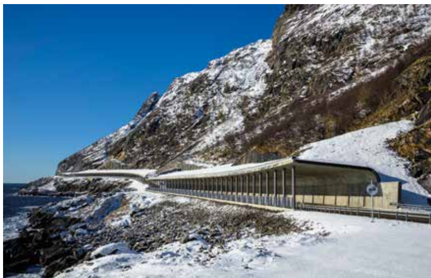
HELHETLIG: Det er bygd fire rasoverbygg i betong på til sammen 955 meter på parsellen mellom Solbjørneset og Akkarvika. Foto: Steinar Skaar/ Statens vegvesen
