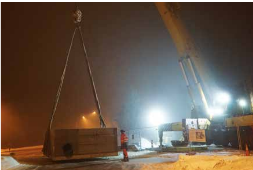
KRAN: En største mobile kranene - 500 tonn - som er å oppdrive i Norge må til for å løfte kummen på plass. Foto: Mona Sprenger
