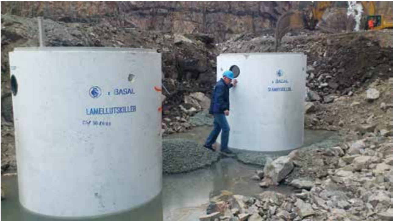
Å montere Basals lamellutskiller er som å montere en hvilke som helst ordinær kum, ifølge entreprenøren. På bildet Odd Erling Stormyr fra Sylteosen Betong.
