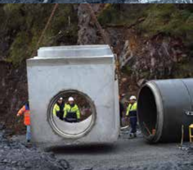
laget bunnseksjonen til nedstigningskummen. Bunnseksjonen er 3,2 meter onn.
