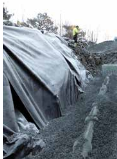
Om lag fire kilometer grøfter blir prosjektet Haukås Deler av arbeidet gikk helt som forventet.
