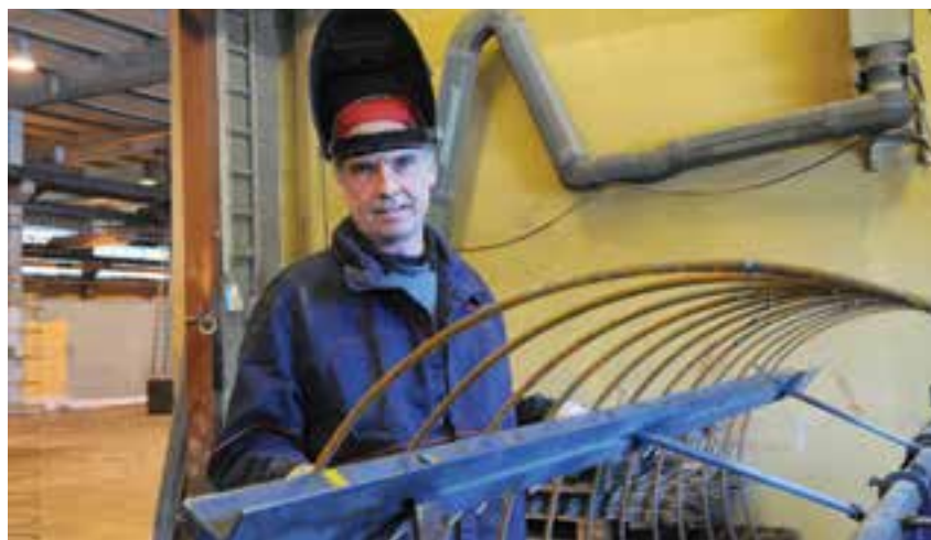
Ole Bjørk er i ferd med å sveise armeringen til nok et ig-rør.
