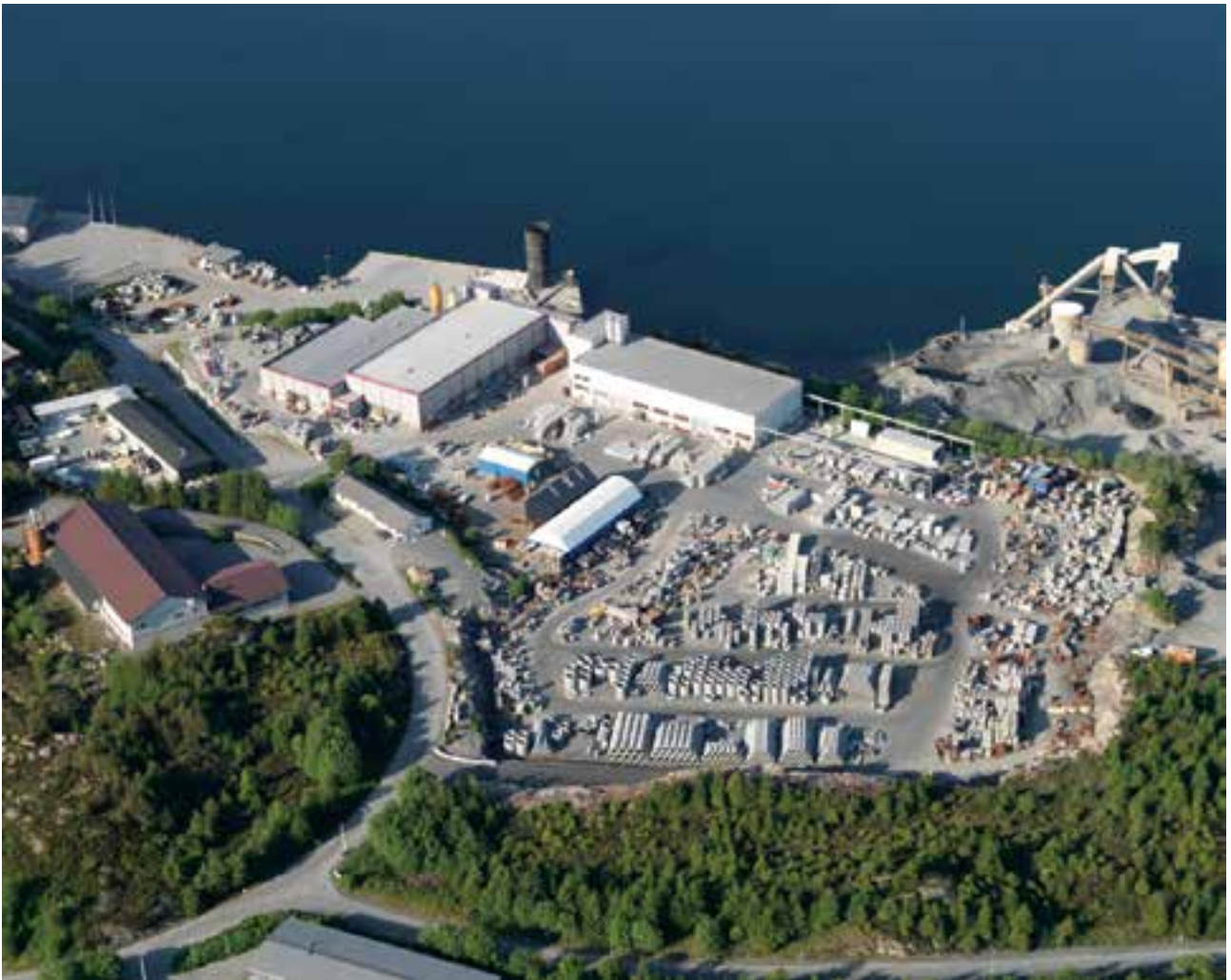
Nobis fabrikk på Askøy ved Bergen. Etter at bildet ble tatt er produksjonshall langs sjøen forlenget. Nå utvides det utvendige lageret inn i området med skog og fjell nederst til høyre. I tillegg bygges nytt siloanlegg for tilslag, slik at lagerkapasitet mer enn doubles.
