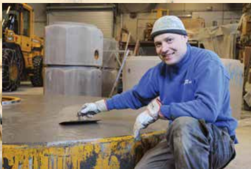
Nå produserer Holmen Betong AS også de største dimensjonene. Her er Stian Nilsen i ferd med å pusse en topplate på DN 2500.
