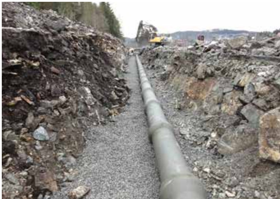
Fjell, skog og myr. Grunnarbeidet viste seg å bli mer utfordrende enn ventet, men etter omleggingen av prosjektet går alt rett veg.
