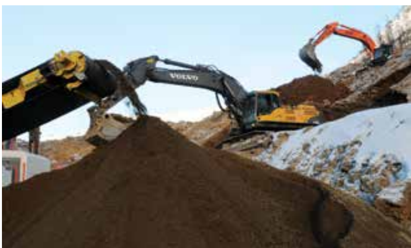
Her, ved Hestvollan, er en ikke så godt fungerende skredvoll. Den skal bygges om, samtidig tar de ut masse til vegkroppen herfra.
