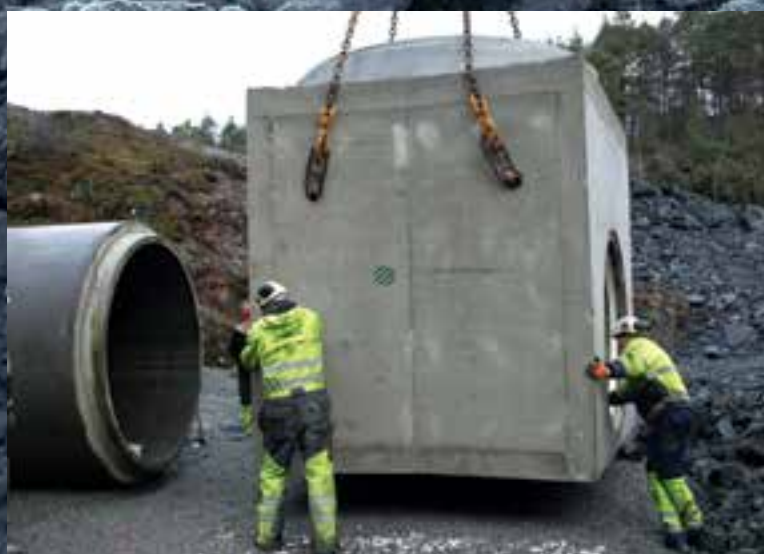
Bunnseksjonen er forrt opp til nesten 8 meters høyde. Til oppforingen er det brukt DN 2500 ringer. Montasjen gikk for øvrig helt greit.
