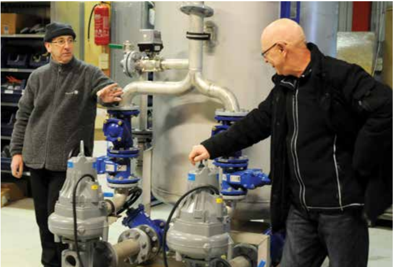
Basal pumpestasjon er utviklet av Partner Vannrens AS og Basal-medlemmet Skjæveland Cementstøperi AS. Basal Pumpestasjon består av et prefabrikkert maskinrom av betong. Ned i denne heises en kloakksump i syrefast stål. Her viser fra v. Aage Gjesdal, daglig leder i Skjæveland Cementstøperi AS og Magne Torgersen fra Partner Vannrens AS frem en kloakksump med pumper.
