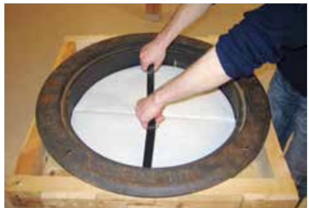
Isolokket er et isolerende lokk som forebygger mot frost i kummer. Lokket føres ned i kummen mens det ennå er sammenbrettet, så løftes det opp og på plass. Da kiler det seg mot sidene i flyterammen og blir værende der.
