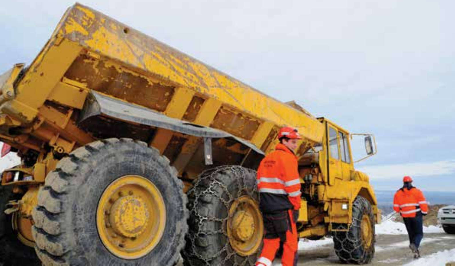
I gjennomsnitt passerer ca. 12 000 kjøretøy i døgnet fv. 84 ved Olrud. Den nye rundkjøringen vil bedre både fremkommeligheten og trafikksikkerheten betraktelig. Her er fra venstre anleggsleder Christopher Haverstad og Geir Inge Krok, og i bakkant en Volvo dumper på 16 tonn.
