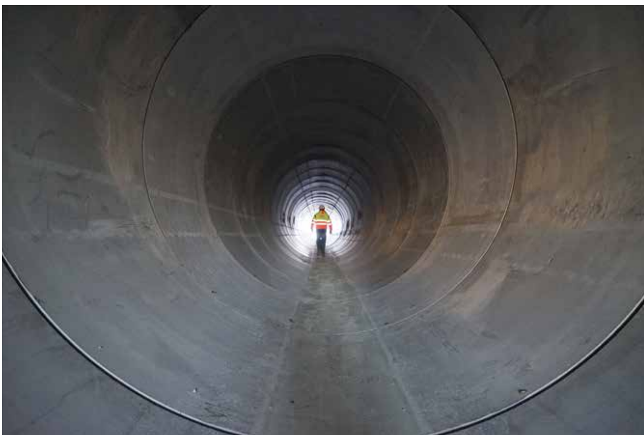
NORGES STØRSTE AVLØPSRØR: På E6-prosjektet mellom Jaktøyen i Melhus og Sentervegen ved City Syd i Trondheim legges DN 3000 ig-falsrør. Det er første gang i Norden brukes ig-falsrør DN3000 betongrør i et vegprosjekt.
