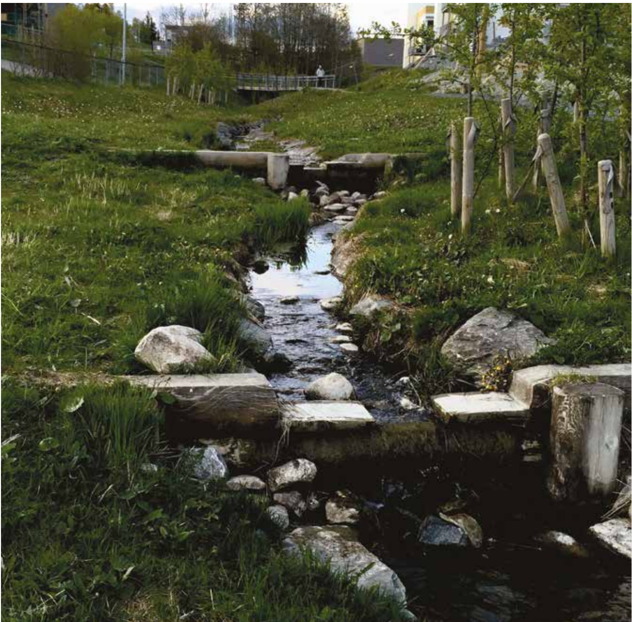
ÅPEN: Overvannsbekk ved Akkebakke i Trondheim. Foto: Tone M. Muthanna NTNU
