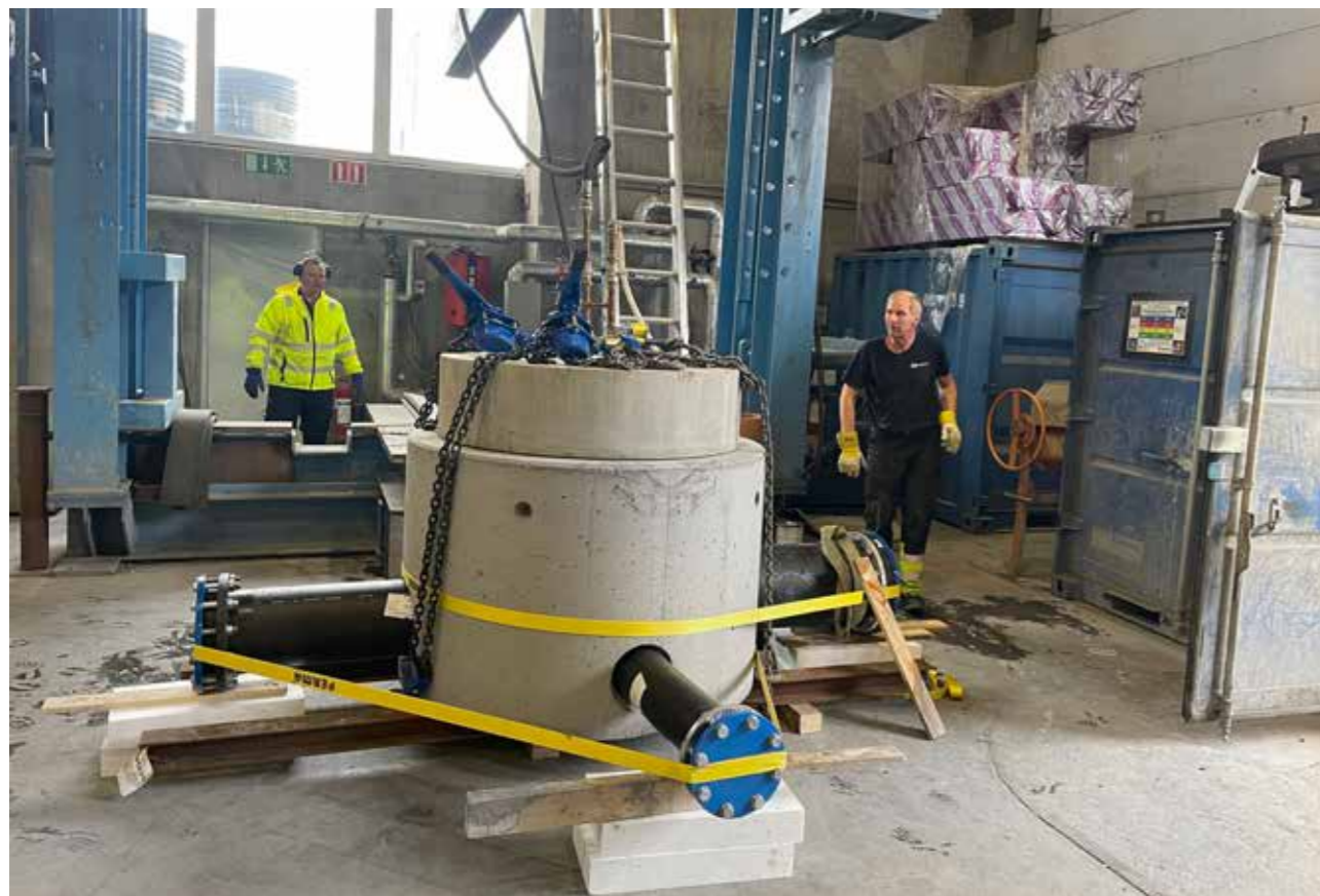
TESTOPPSETT 1: Kummen ble fylt med vann og påført et trykk på 0,5 bar. Ingen lekkasje ble registrert.
