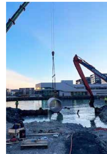
RØR I SOLNEDGANG: En ny seksjon klargjøres for montering under solnedgangen før den senkes ned i sjøen.
