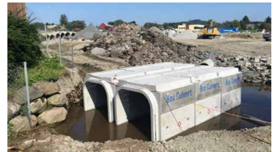
KREVER LITEN PLASS: Boks Kulverten har fordeler hvor det er liten plass i grøften eller fjellgrøft.
