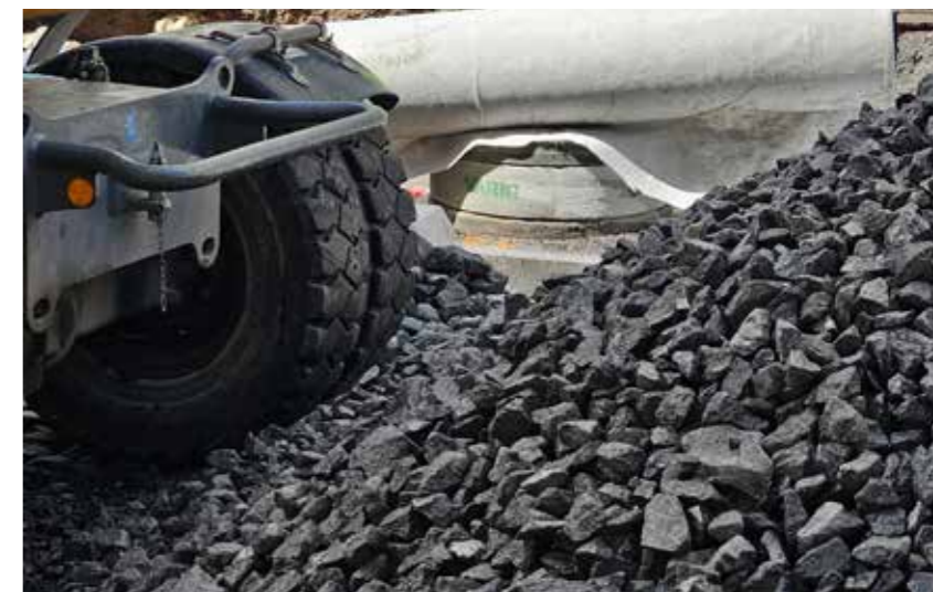
ETTER: Ferdig nedsenket blir kummen pakket med grove omfyllingsmasser, noe som viser ett av fortrinnene til kummer av betong.
