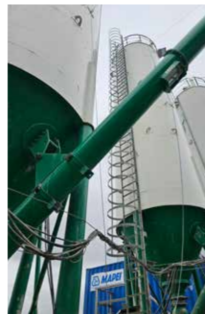
KORTREIST: Ølen Betongs mobile blandeverk sørger for kortreist betong til Oslos nye rentvannstunnel.
