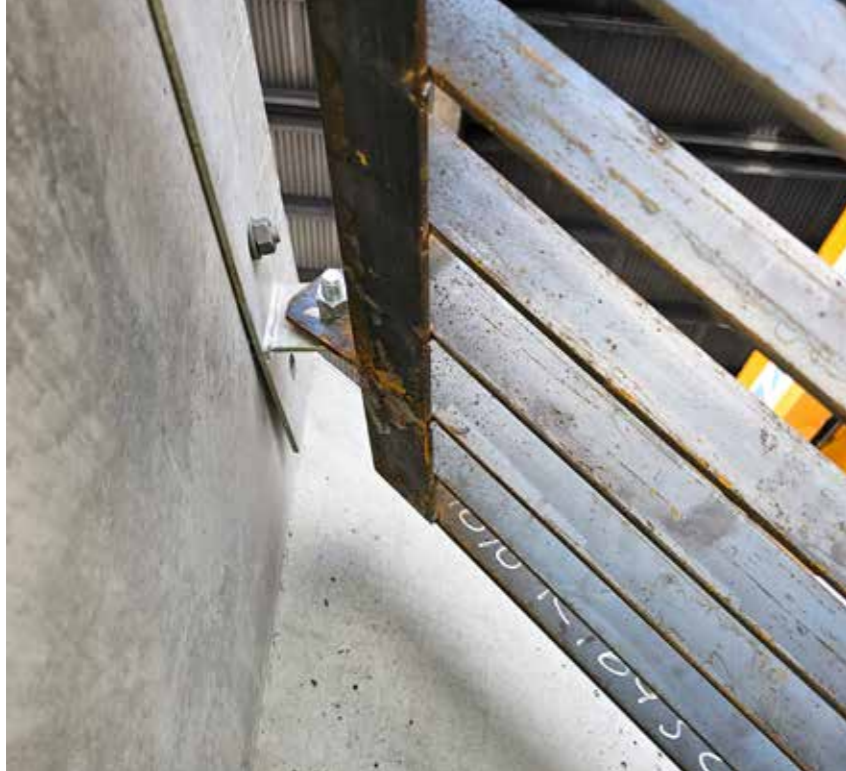
HENGLER, ELLER IKKE HENGLER?: Pål-Steinar Karlsen i SVV var skeptisk til at prototypen hadde hengsler. De vil gjøre det vanskeligere å heve rista rett opp under en flom. Han foreslo at man heller la rista i en slisse som holdt den på plass i overkant.
