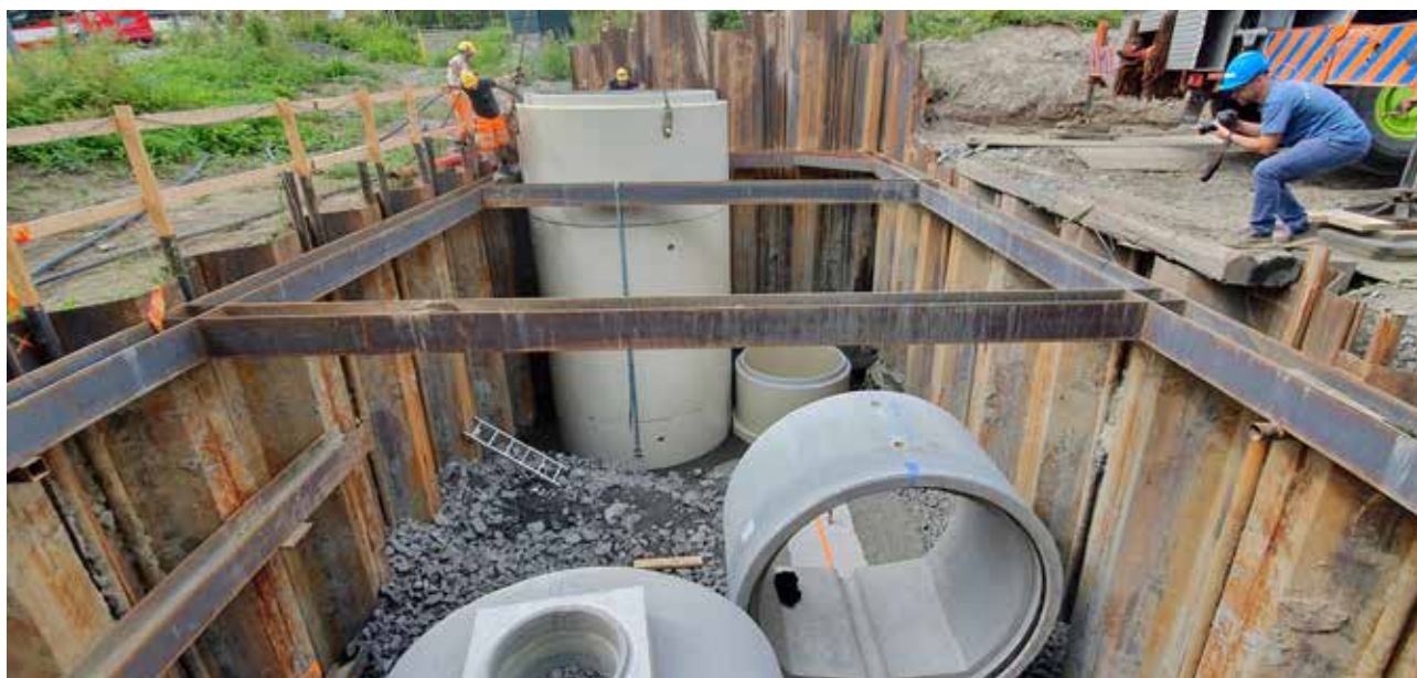
NORDRE FOLLO: I byggefase, august 2019. (Foto: Axflow)
