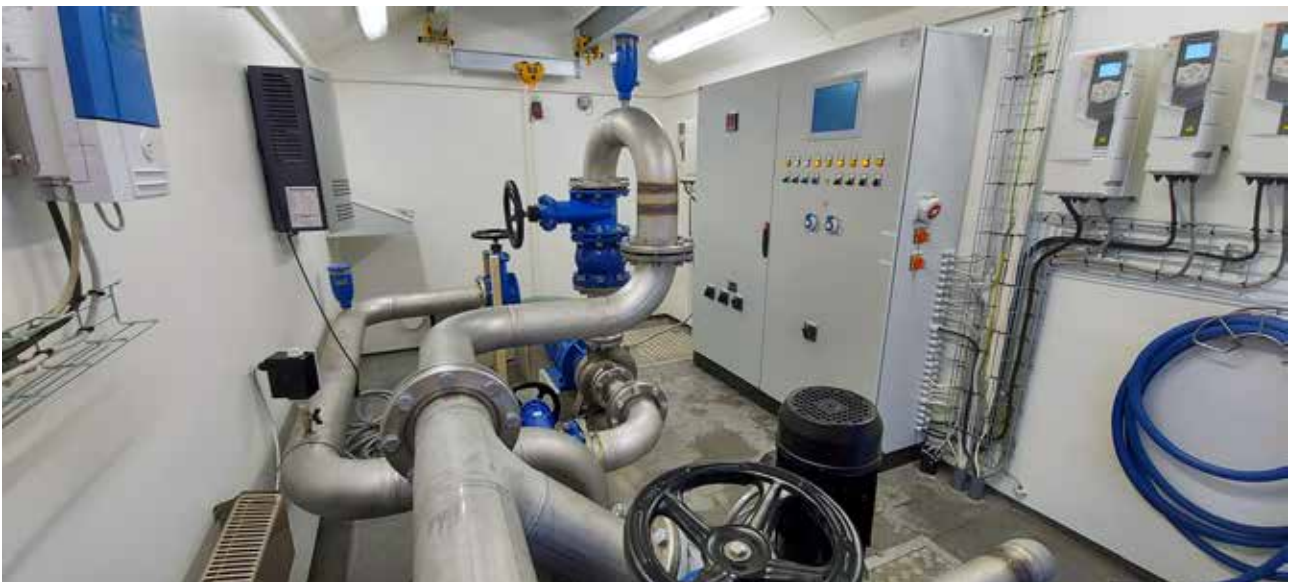
PUMPEHUS: Intec Pumper installerer alt i overdelen. Slik ser det ut når det fraktes ut. (Foto: Knut Bjerke AS)
