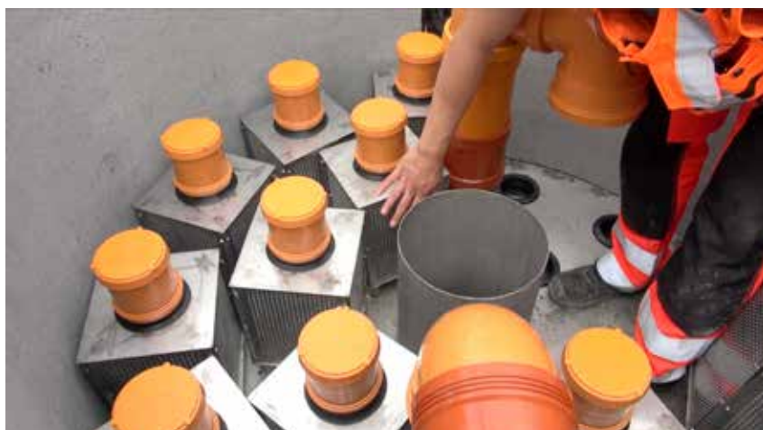
TT-ECO-FIBER: Telemark Technologies har patentert et fibermateriale som trekker til seg fettbaserte miljøgifter.
