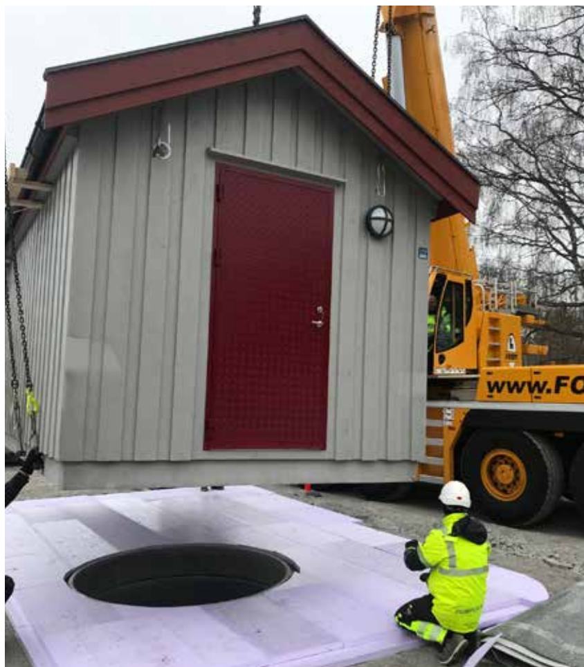
KOMPLETT: Komplett overdel til pumpestasjonen settes på plass på Hafslundøy ved Sarpsborg. (Foto: Østfold Betongprodukter AS)
