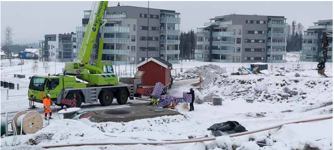
KOMPLETT: Levering av overdel til en trykkokningsstasjon på Sole i Vestby. (Foto: Knut Bjerke AS)
