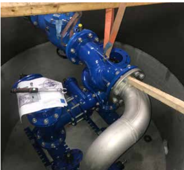
BLÅDELER: Blådeler monteres i kummen hos Østfold Betongprodukter AS på Mysen.
