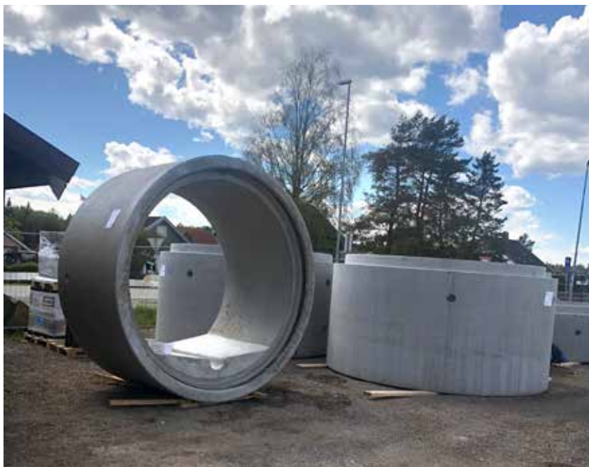
MYE BETONGVARER: Det meste standard prefabrikkert. Ringene til tankene (bildet) fikk en istøpt renne til sumpen. (Foto: Nordre Follo kommune)
