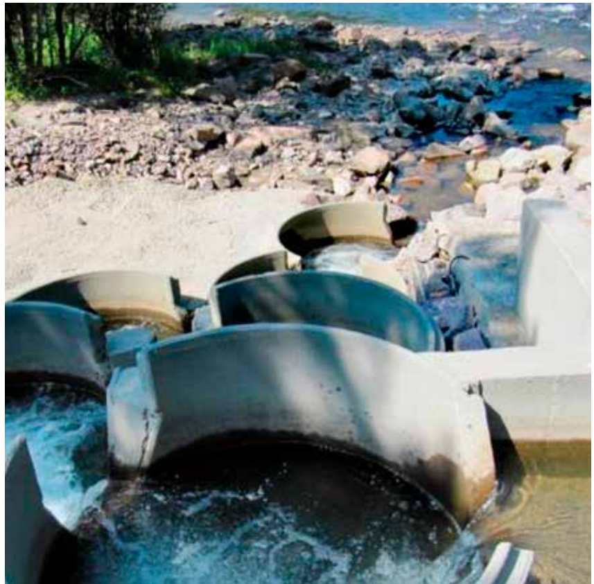
Betongrør med tilpassede åpninger utgjør fisketrappa i Hemselva. Bildet er fra Statens vegvesens rapport Nye fiskeveger. (Foto: Sigrun Børresen)
