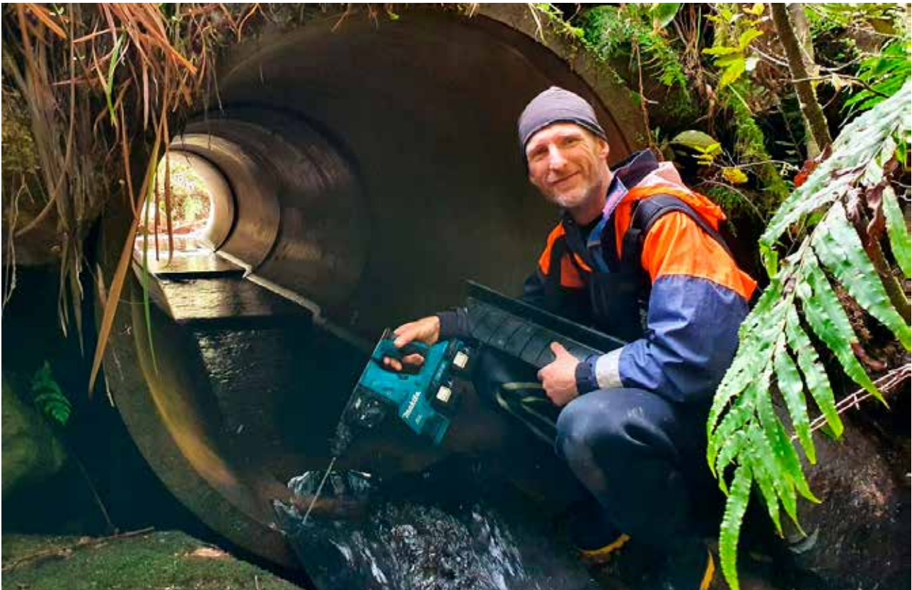
ENKEL MONTERING: "Baffles" ettermonteres med enkle midler i rør. Så lenge det er stort nok til å komme inni, vel å merke. Bildet er fra New Zealand. (Foto: ATS Enviromental)
