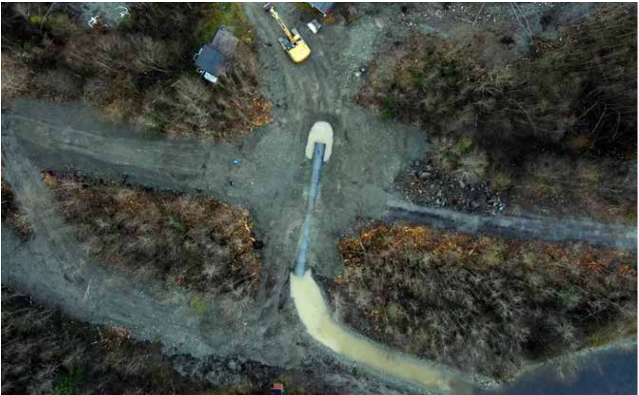
SOLIDE BETONGRØR: Ny kulvert gjennom elveforbygningen, der den viktige sjøørretbekken Tonga møter Orkla. (Foto: Ole G. Heggen)
