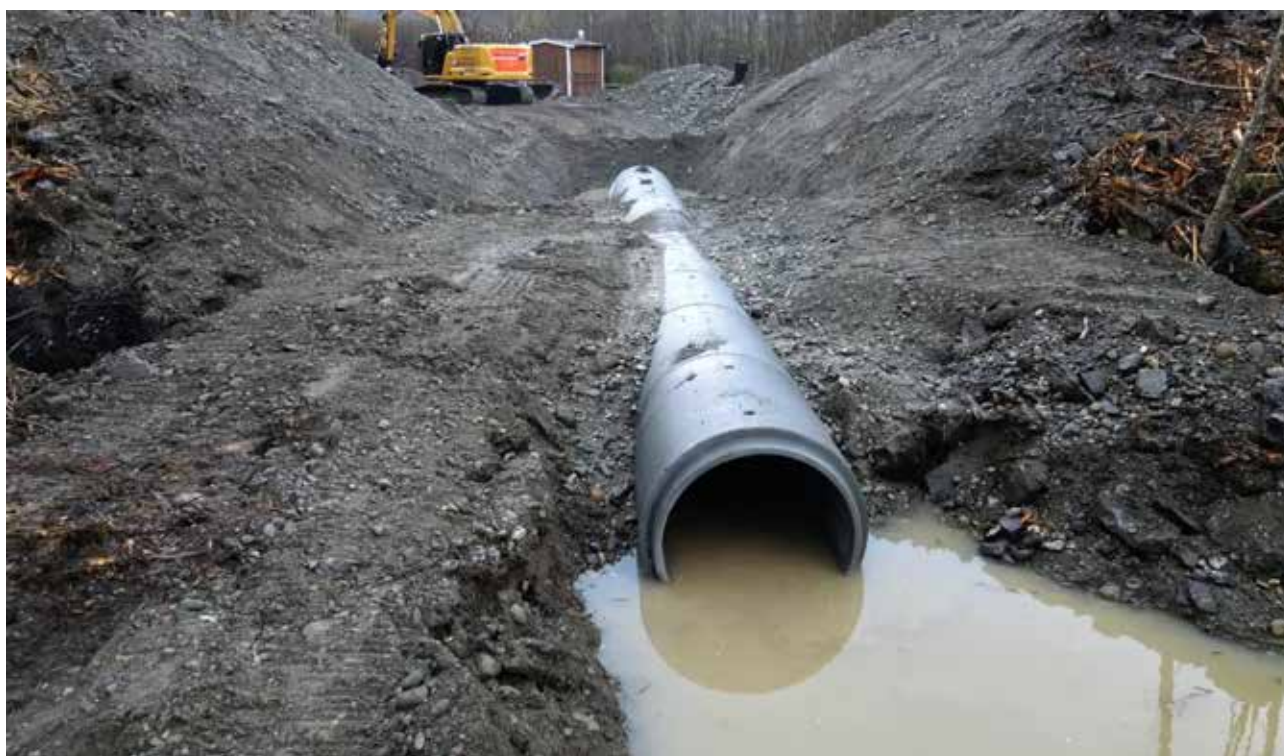
LIGGER LAVT: En fiskevennlig stikkrenne ligger lavt i terrenget. (Foto: Ole G. Heggen)
