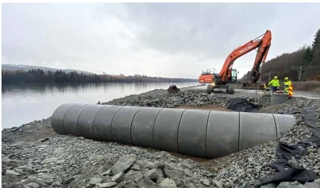
ROBUSTE RØR: 2400-rørene legges i en nedre kvartsirkel 8-16, og omfylles med 20-120 mm kult til 250 mm over topp rør. (Foto: Jon Arild Holte, Loe Rørprodukter AS)
