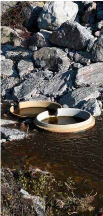
Betongrør med tilpassede åpninger utgjør fisketrappa i Hemselva. Bildet er fra Statens vegvesens rapport Nye fiskeveger. (Foto: Sigrun Børresen)
