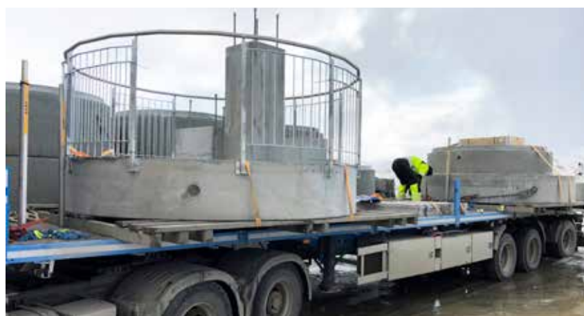
MONTERT: Topplate med pidestall. Settes på 3000 mellomdekke med overgang til 2400. Til dette tårnet i Hasvik ble mye av utstyret ferdig montert på fabrikk.
