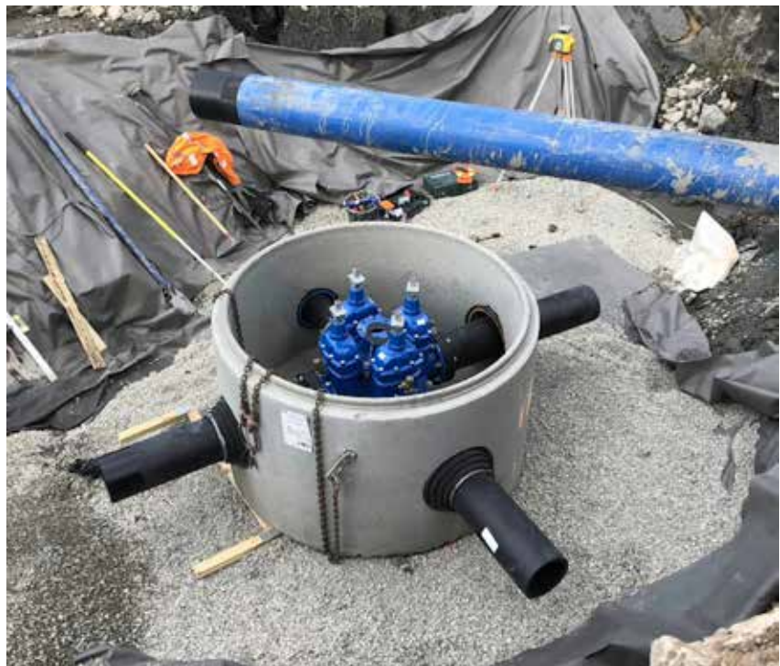
UNDERLAG: Avrette og komprimere underlaget. Sett ned kummen, og den er umiddelbart klar til å koble rør. (Foto: Isachsen Anlegg)
