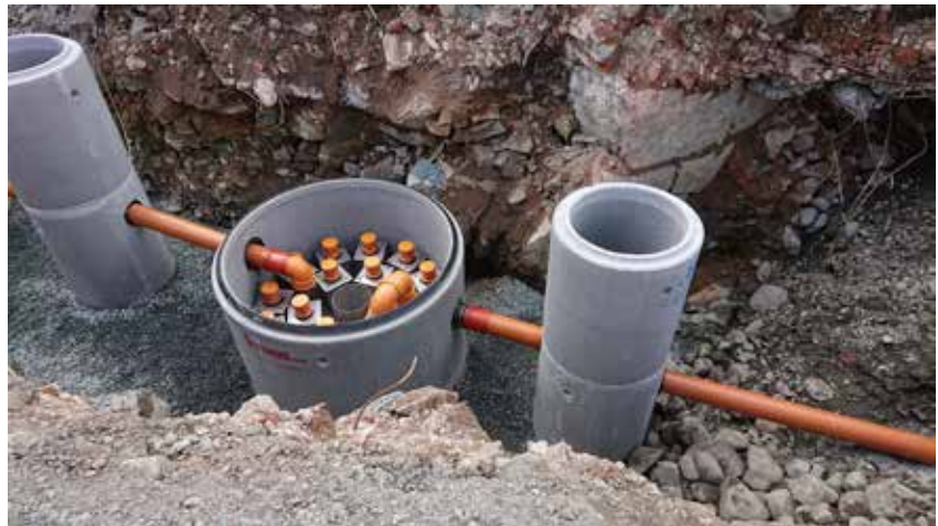
STANDARD: Miljøkummen er en standard kum utvendig, med avansert filterteknologi innvendig.
