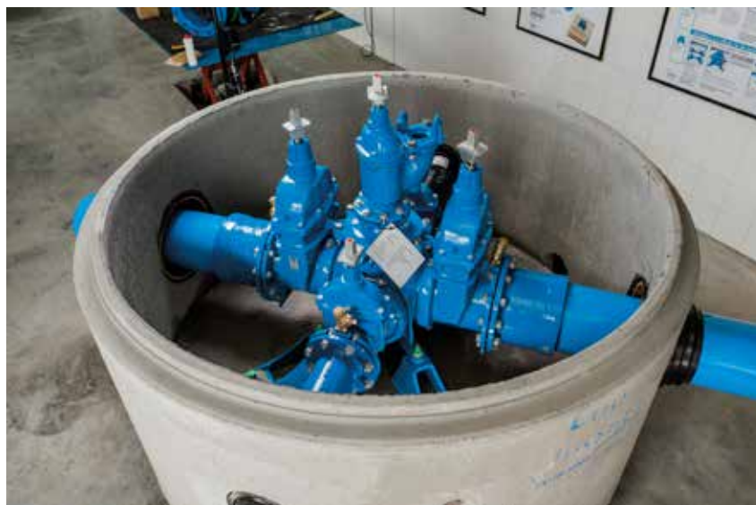
FERDIG MONTERT: Det blir mange bolter som skal skrues i en vannkum.
