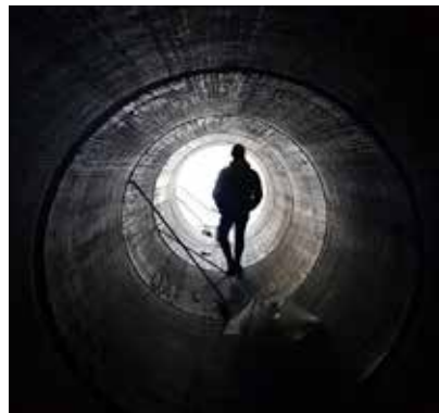
TUNNEL: Voksne dimensjoner på ledningen og bendet.
