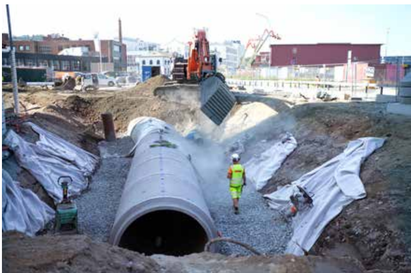
OMFYLLING: Ledningen installeres i Nyhavna Øvre.
