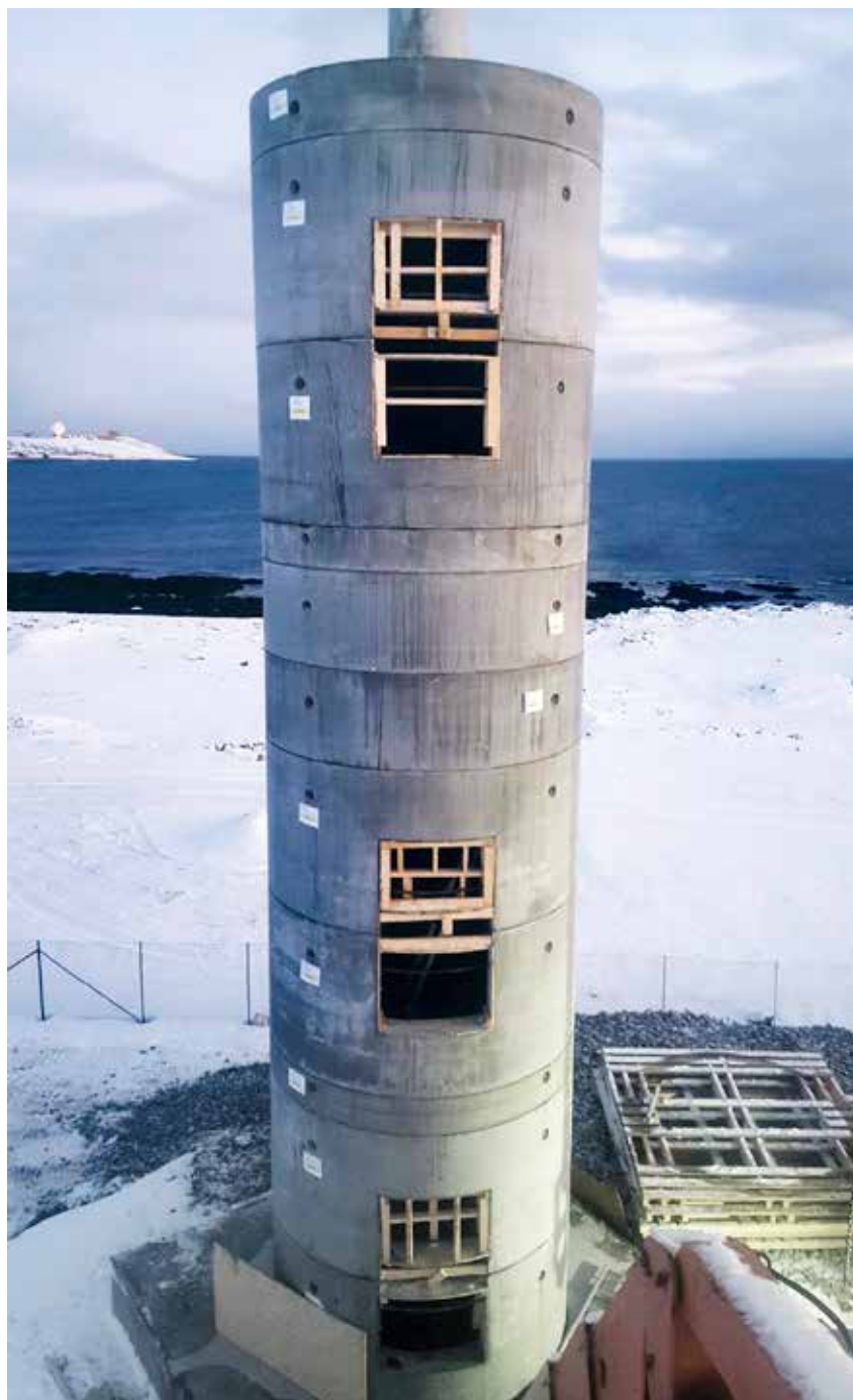
KLART: Betongelementer ferdig montert.
