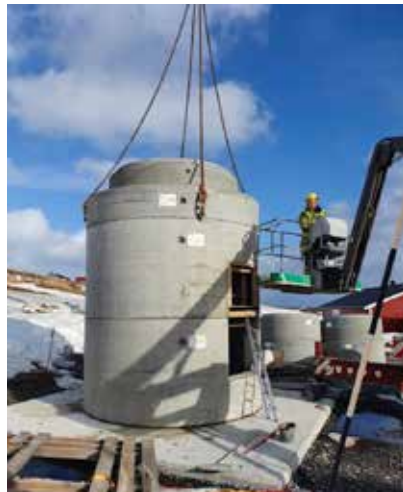
OVERGANG: Montering av spesiallaget overgangsring DN3000/2400 i Hasvik.
