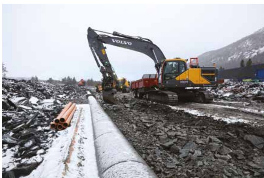
ENTREPRENØR: Hirth Himle Entreprenør AS utfører oppdraget for Voss herad.
