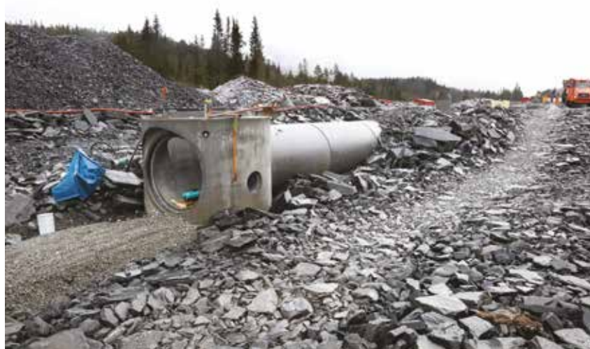
BETONG: 300 tonn betongvarer.
