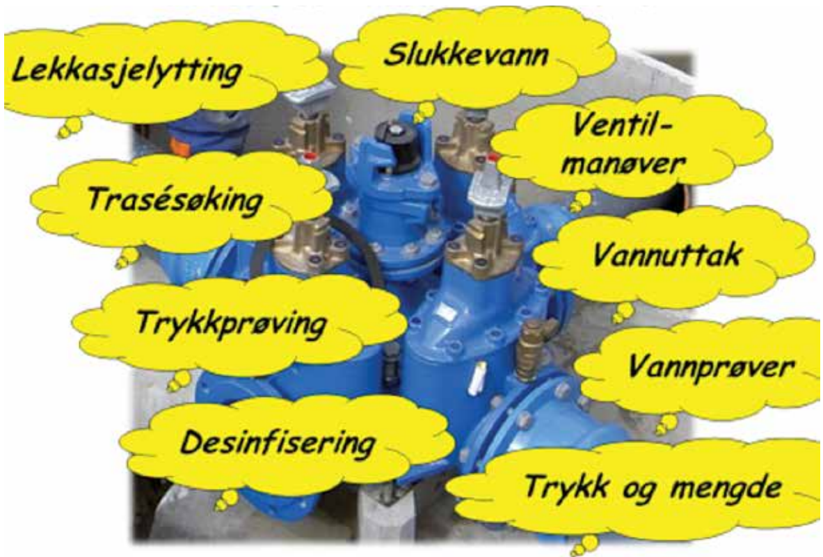
Figur 1. Vannkummens oppgaver (Illustrasjon Arve Hansen, VA-teknikk AS)
